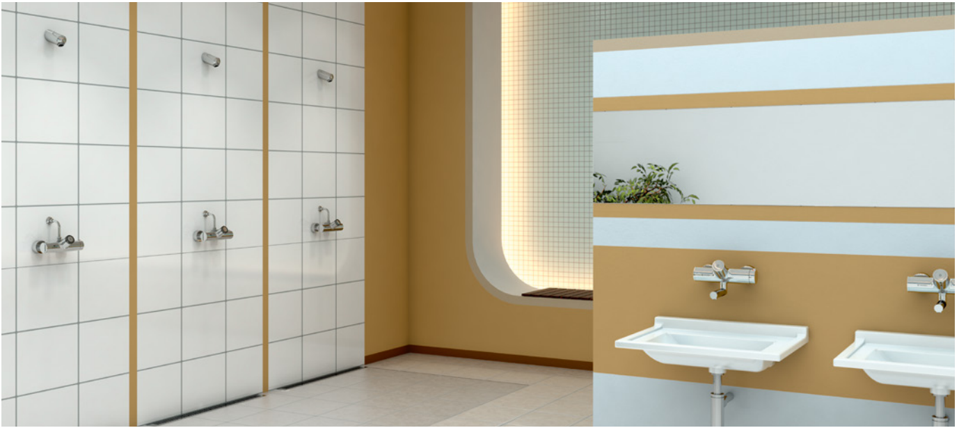
In Großanlagen müssen regelmäßig Proben entnommen werden.
